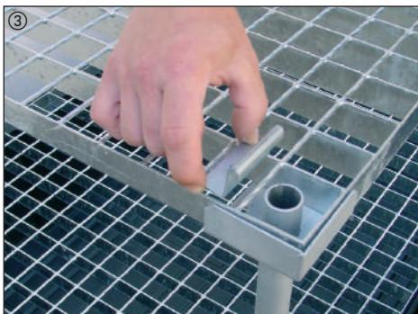
③ 4 x Klemmblech für Stahlgitterrost einhängen.
